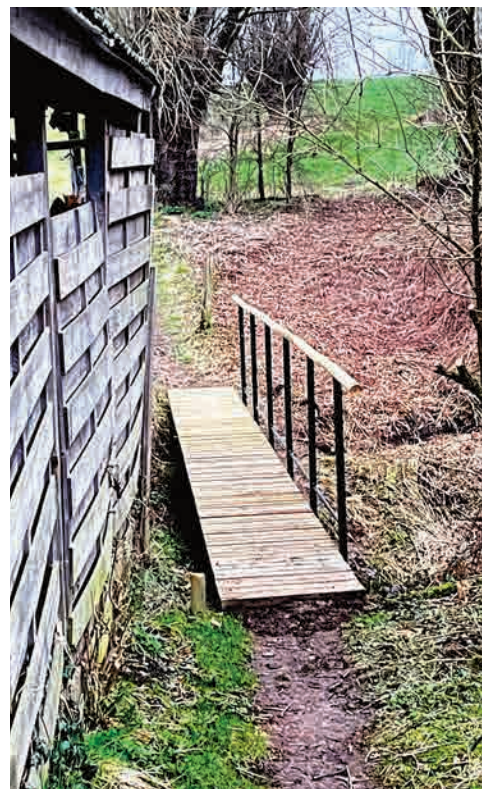
Installation d'une passerelle sur le Sentier de la Chapelle Lepot pour garantir un passage sécurisé aux promeneurs au-dessus du ruisseau.
